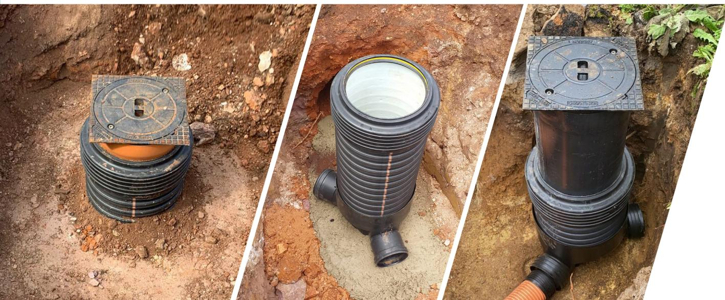
Las arquetas de inspección Ambidur fabricadas por el Grupo Politejo, mediante proceso de inyección, según EN 13598-2, son la solución ideal para sistemas de drenaje sin presión, teniendo como principal aplicabilidad colectores de agua de lluvia, aguas residuales domésticas y vertidos industriales.
